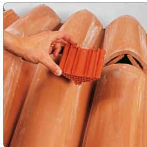
6. lépés: a gerincnél helyezze el a szellőzőnyílásokat a gerinc minkét oldalán.
